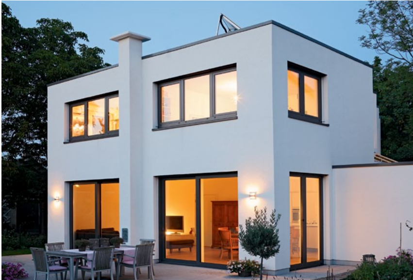
Okna w budynku poddanym modernizacji
